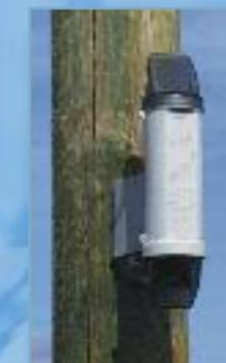
Индикатор неисправностей воздушных линий (6-66 кВ)
